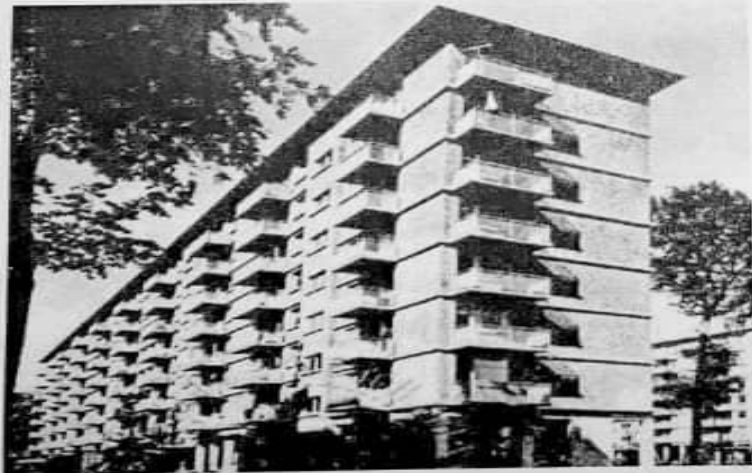
سیستم کاموس یک بلوک ساختمانی از برنامه ۴۰۰۰ واحدی دولت فرانسه در سال ۱۹۵۴
